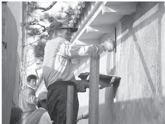
伝統的建造物等の修理・修景
