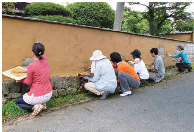
ボランティアによる古民家再生プロジェクト
