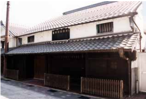
図 3.3-5 出格子窓、ムシコ窓、細格子、荒格子を持つ町家 (下 32)
