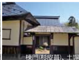
棟門(杉皮葺)、土塀
