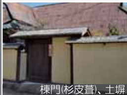
棟門(杉皮葺)、土塀
