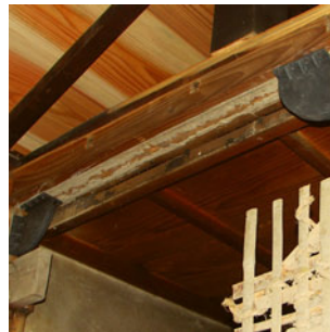
制震ダンパーの設置
