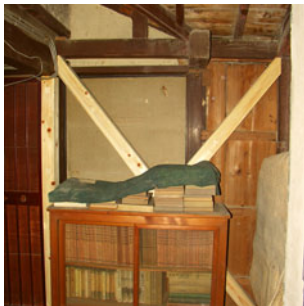
筋交いの設置
