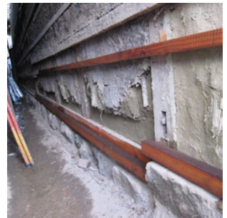
土台取替え・基礎改修
