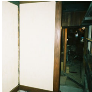
耐力壁の設置
