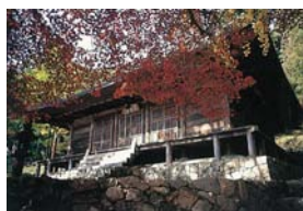
大國寺本堂(味間奥) 【国指定重要文化財(建造物)】
