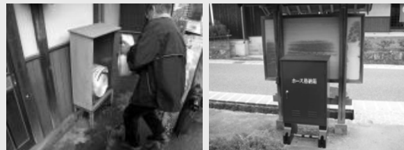
防災設備の整備
