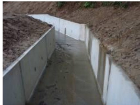
▲コンクリートで固められた水路
