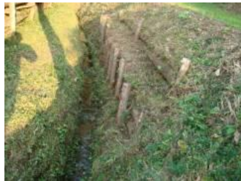
▲木杭による水路
