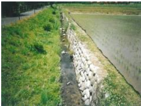
▲片側は自然護岸、片側は石積みによる水路
