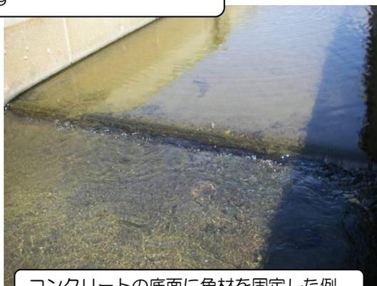
コンクリートの底面に角材を固定した例
