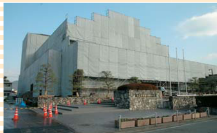
足場で囲われたホール全景
